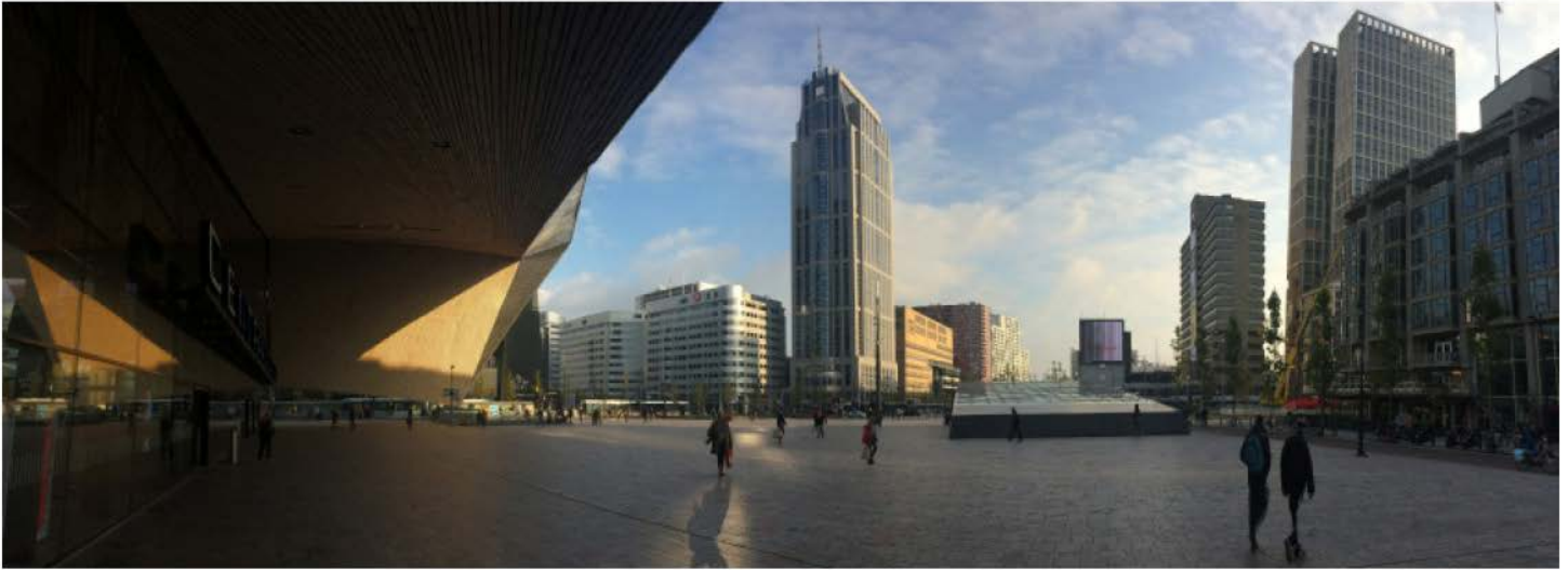
Rotterdam Centraal Station Plaza, Benthem Crouwel Architects
